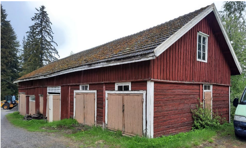
Kuva 7. Kunnantalon pihalla oleva varistorakennus
