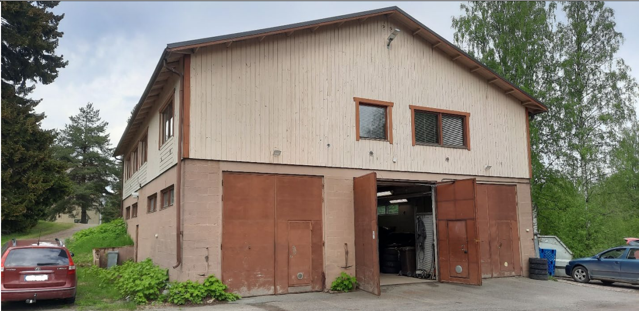
Kuva 5. Entinen teknisen viraston rakennus.
