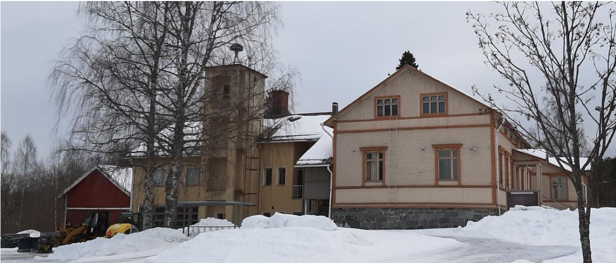
Kuva 2. Ristiinan entinen kunnantalo pohjoisesta kuvattuna.
